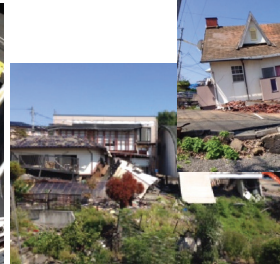
倒壊家屋等の状況
