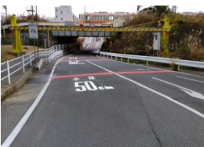
西枇杷島中学校前アンダーパス 路面標示の実施
