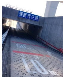
廻間アンダーパス 路面標示の実施
