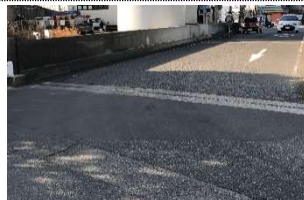
国道 302 号架空線(一場) ジョイント段差解消
