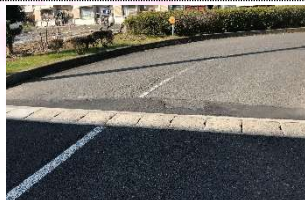
国道 302 号線(西市場) 横断側溝段差解消
