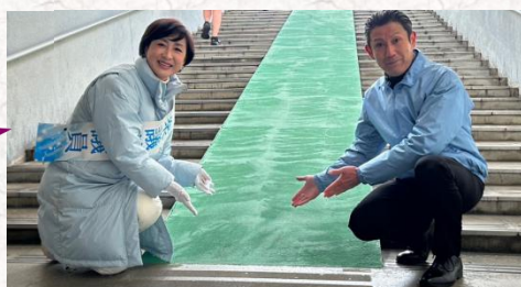
新清洲駅地下通路スロープの滑り止め舗装工事の完了を衆議院議員岬まきさんと確認
